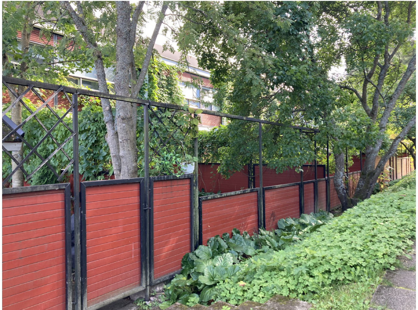
As Oy Korte-rannan (15-5) piholla olevia Arnold Lerberin suunnitelmien mukaan rakennettuja yksityispihojen aitoja, joissa on yhdistelty erikokoisia aitaelementtejä.
