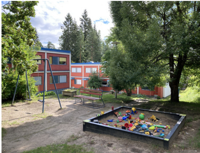
Leikkialueiden alkuperäisiä kunnostettuja keinurunkoja.
